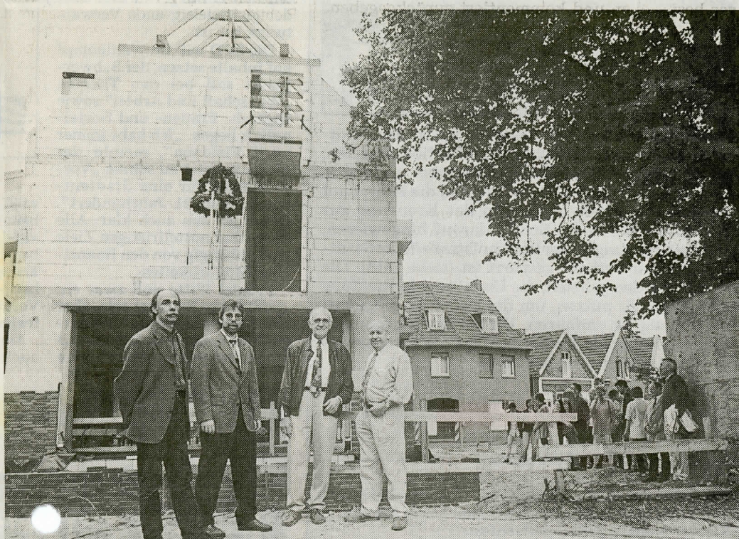
Der Richtkranz weht an der Volksbank. Unsere Aufnahme zeigt von links: Architekt Manfred Ströcker, Vorstand Manfred Sondag, Vorstand Siegfried Oldekamp und den Aufsichtsratsvorsitzenden der Bank, Arnold Werning, vor dem Rohbau.
